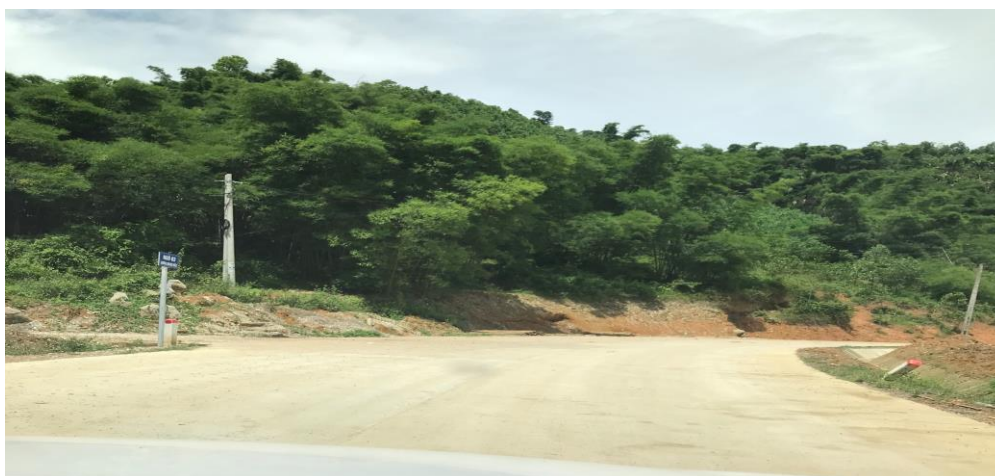
Hình 1. 2. Hiện trạng tuyến đường giao thông tại khu vực dự án
